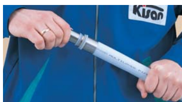
Osadzenie złączki zaprasowywanej Насадка запрессовываемого соединения Mounting pressed coupling
