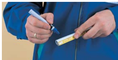
Zaznaczenie głębokości osadzania złączki Разметка глубины ввода трубы Marking the coupling's mounting depth
