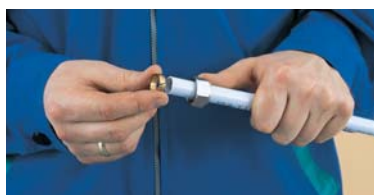
Nałożenie przeciętego pierścienia złączki VESTOL ZBK Насадка разрезного кольца соединения VESTOL ZBK Putting cut ring on VESTOL ZBK couplings
