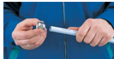
Nałożenie nakrętki Насадка гайки Inserting nut
