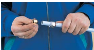
Osadzenie korpusu złączki VESTOL Насадка корпуса соединения VESTOL Mounting VESTOL coupling body
